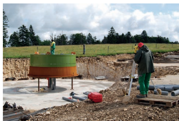
Construction du socle d'une éolienne sur une assise calcaire.
